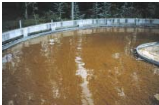
Figure 14– Voile de boue haut dans le clarificateur
