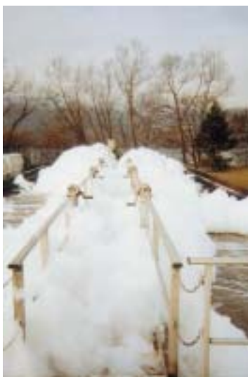
Figure 7 – Mousse blanche de démarrage en surface de bassin d'aération.
